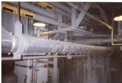
**Protection biologique fixe avec trappe d'accès pour contrôle d'une vanne dans la centrale d'Almaraz**
