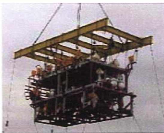
Condensate Demineralizer Module
