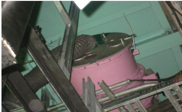
D2O Vapor recovery Inlet
